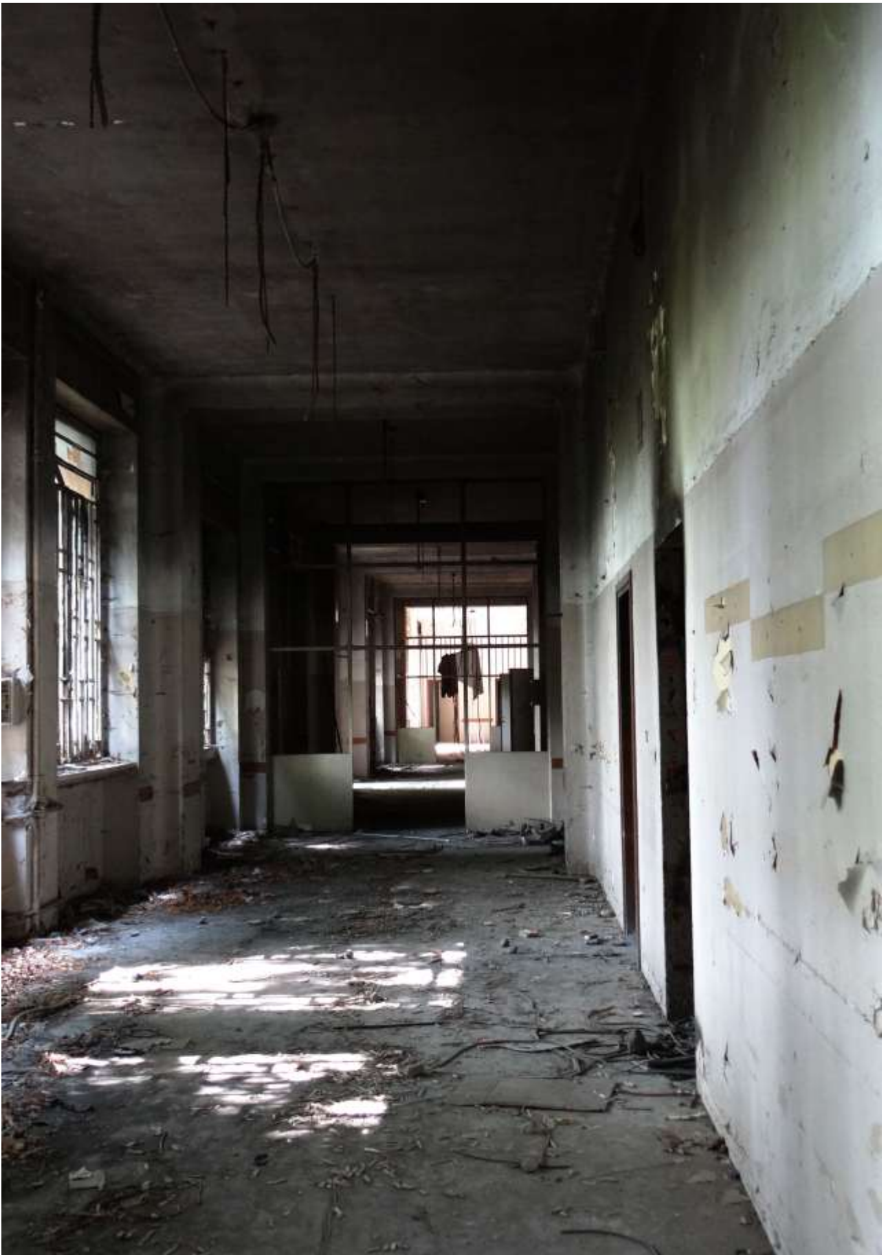
Corridoio, ex ospedale psichiatrico.
